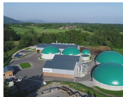
Vue aérienne du site de Terragr'Eau
