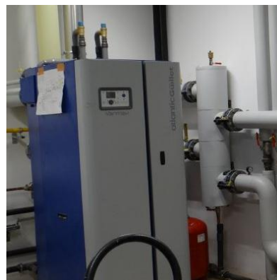
Chaudière à condensation gaz naturel
